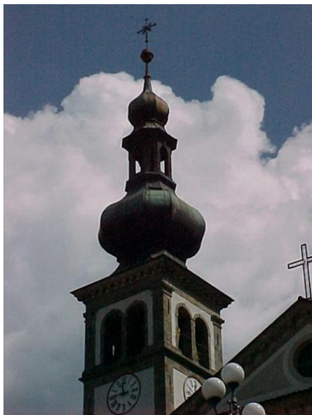
Il campanile: una struttura snella e armoniosa
